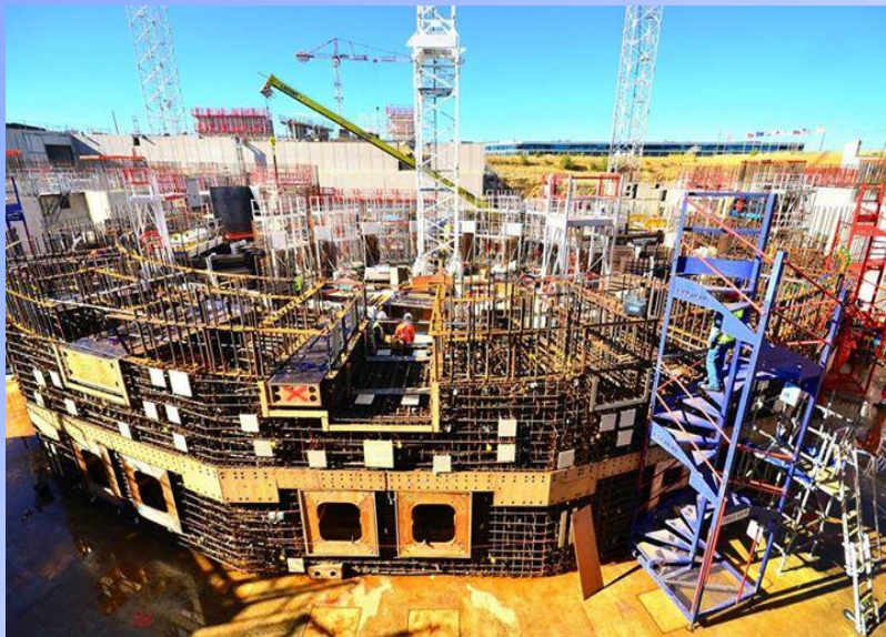
Cadarache – plac budowy instalacji ITER (wrzesień 2015)
